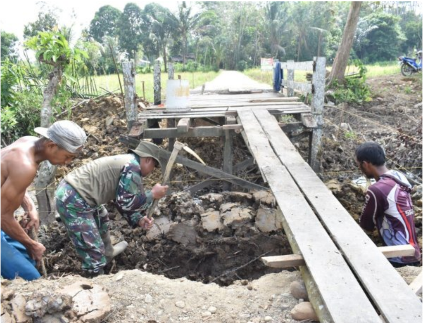
Abutment Jembatan Dikerjakan Satgas TMMD Ke-116 Kodim 1002/HST
