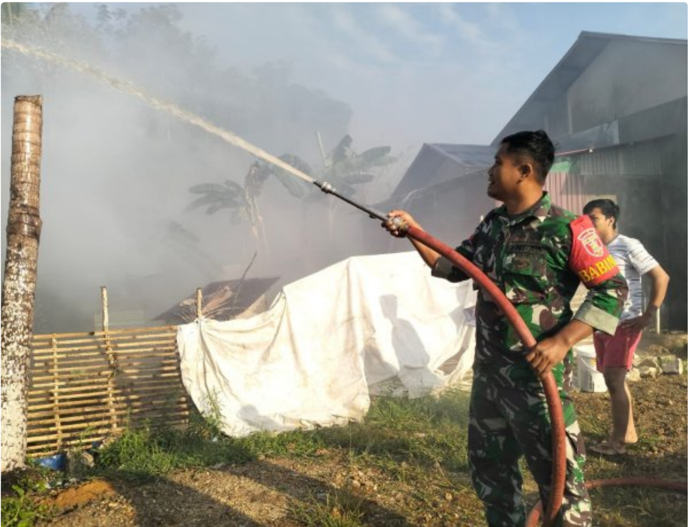
Babinsa Kodim 1002/HST Bantu Padamkan Kebakaran Gudang
