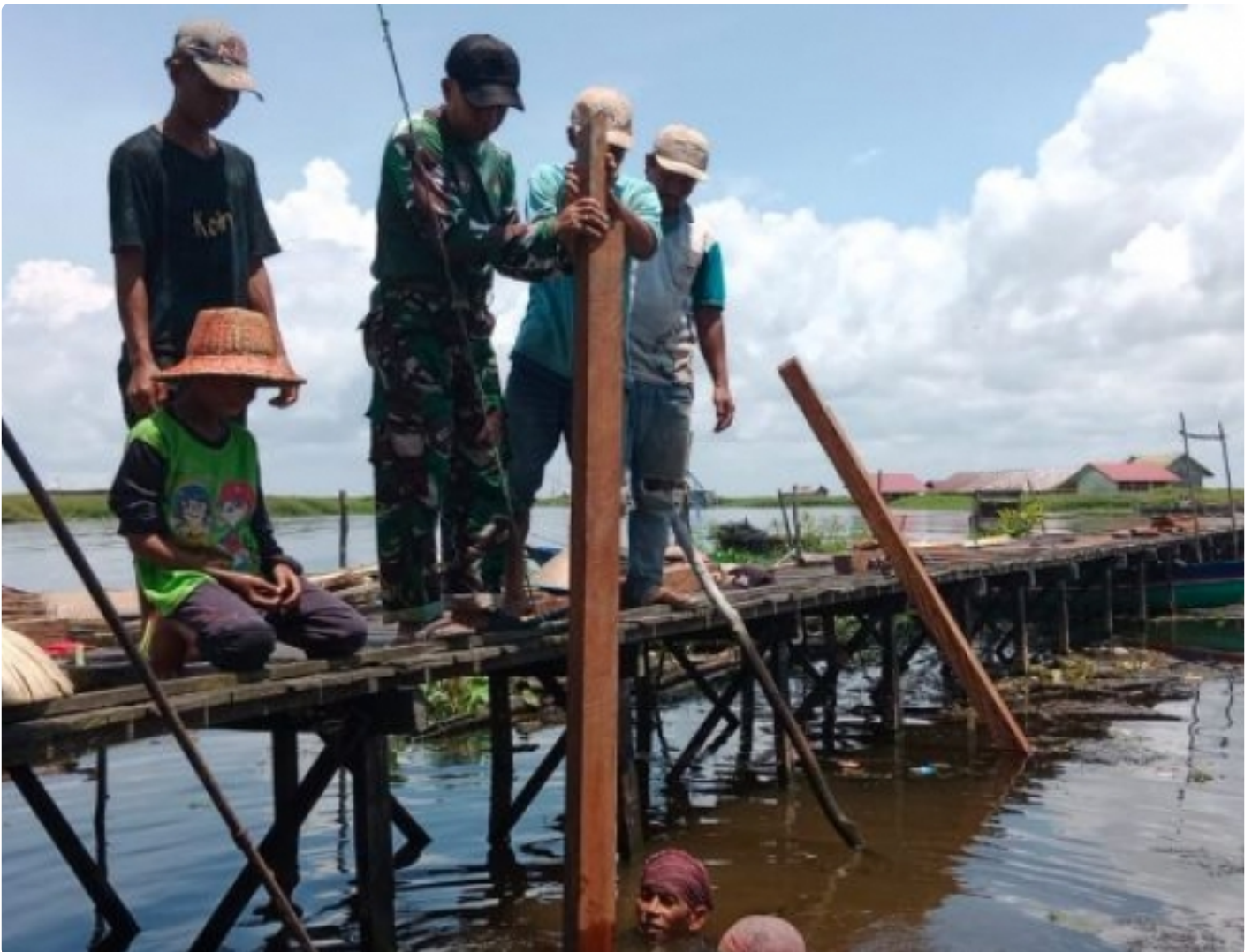
Pemasangan Tiang Penampungan Air
